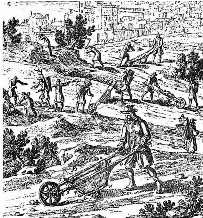
La fabrication d'une route sous Louis XIV avec des pics, des hottes et des brouettes, d'après la Géométrie pratique de Manesson-Mallet (1702). (Plon - J. Da Cunha)
